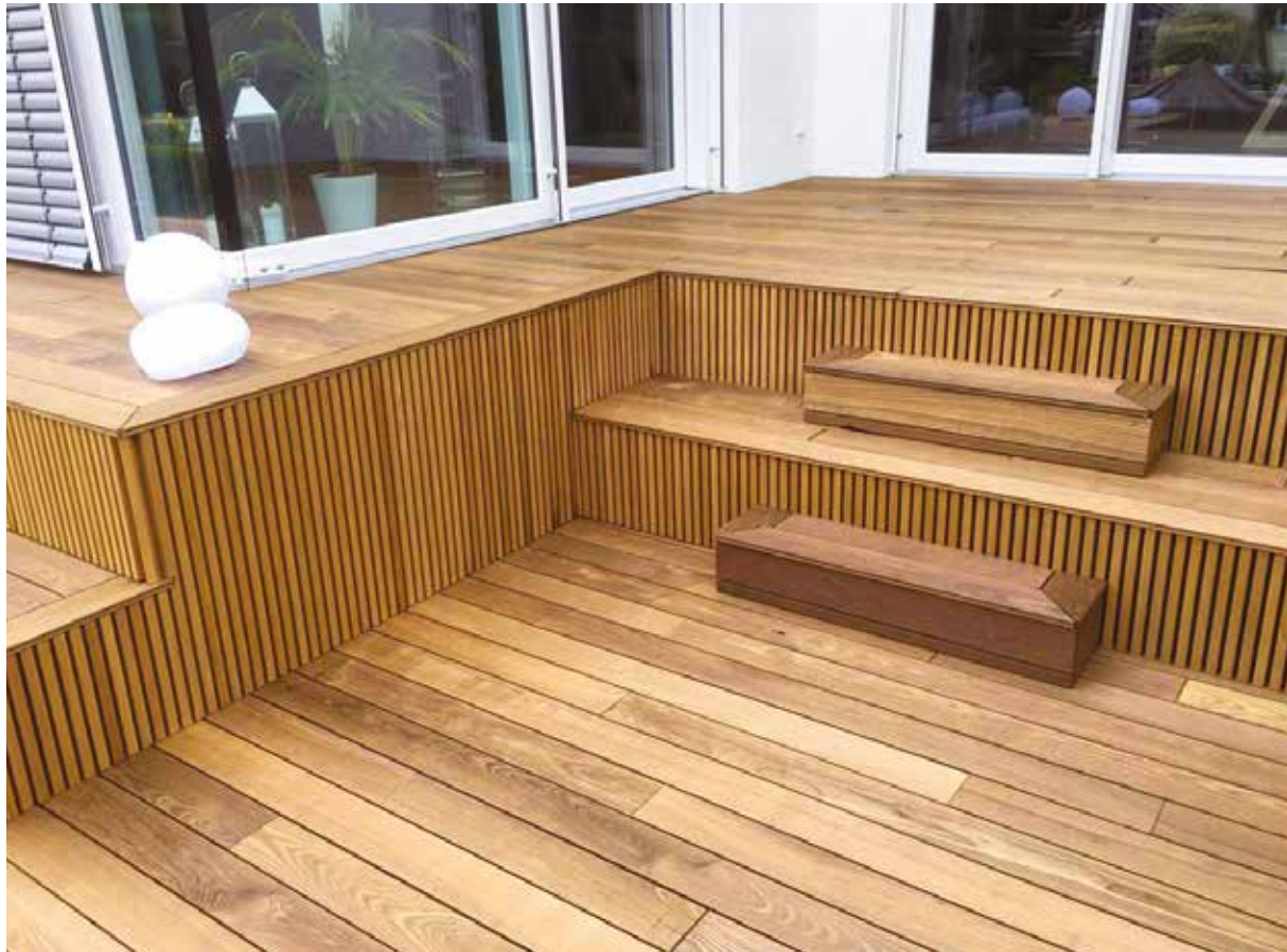
Villa: Holzterrasse mit FERRADIX® ALPHA und Holzpfostenträger (Zubehör Gothischer Träger)
