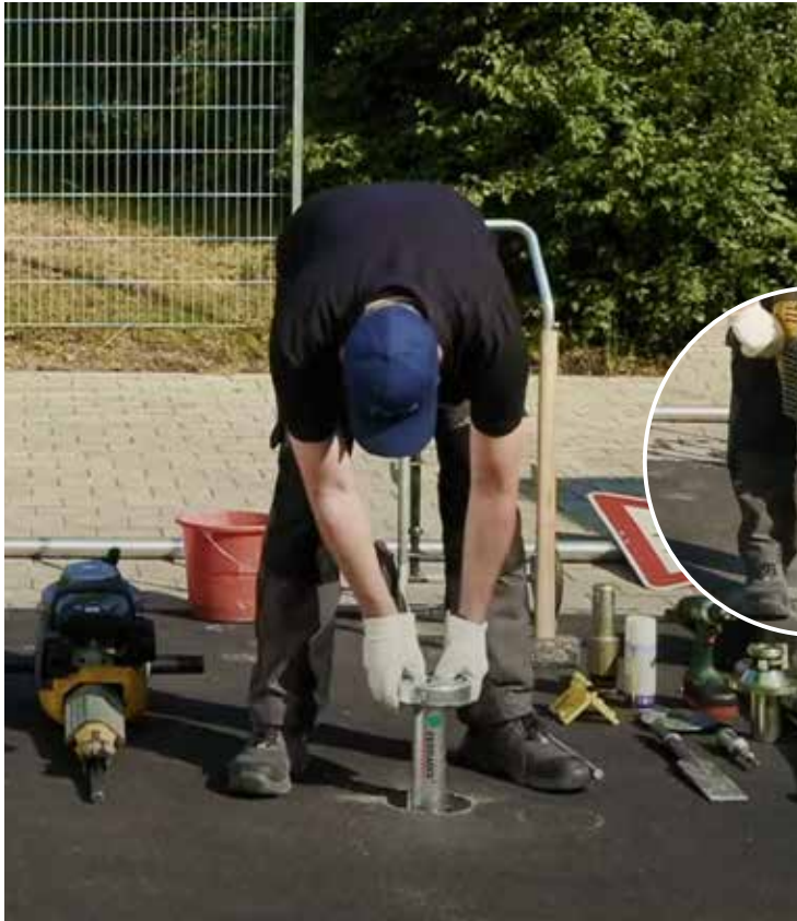
3. Ferradix einsetzen und mit dem „Einschlagwerkzeug“ eintreiben.
