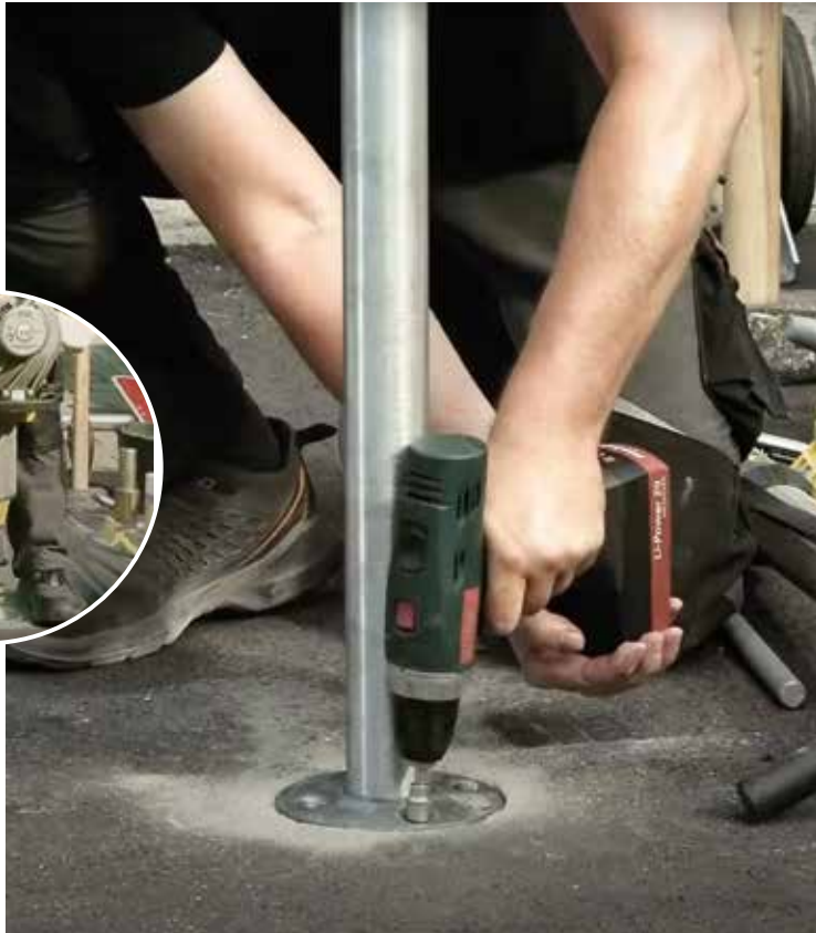
4. Schilderpfosten mit „Spann-Set“ festschrauben.
