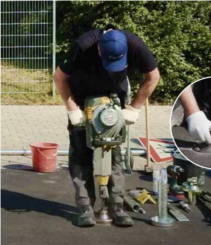
1. Mit „Topfmeissel“ die Oberfläche öffnen.
