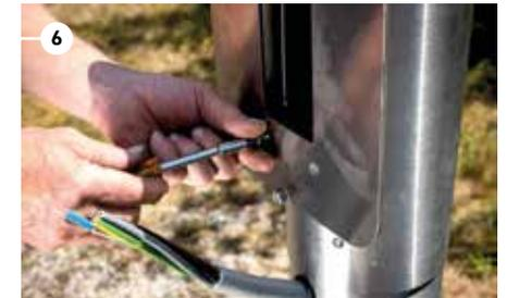
6. Kopfteil mit universal-Adapterplatte anschrauben. Funktioniert Dank Universal-Adapterplatte mit **allen** Wallboxen.
