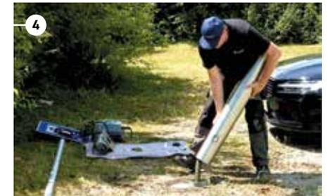
4. Edelstahlsäule aufsetzen (Kabel innenliegend)
